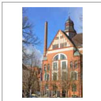
Die Avilix Group AG residiert im Skandinavienhaus im Pelikanviertel
